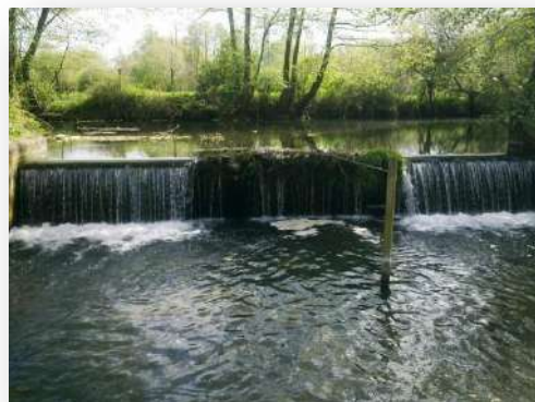
Photo 80 : déversoir du bras des moines
