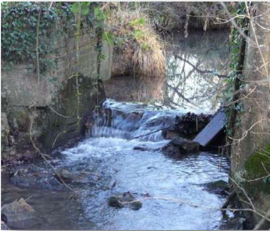
Photos 57 : seuil dans le camping
