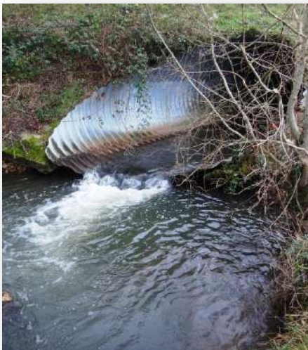
Photo 94 : franchissement de la RD 33
