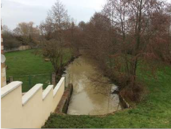
Photo 92 : aspect de la Ste-Rose à l'aval de l'étang des Noues
