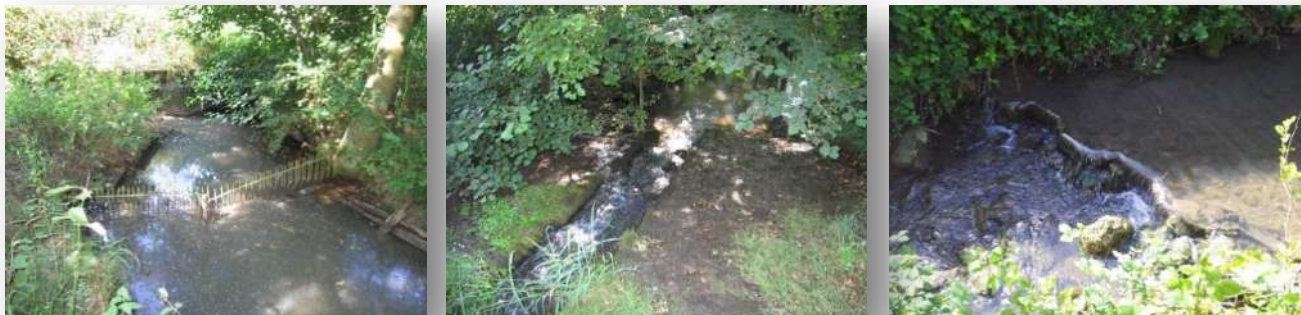
Photo 15,16 &17 : Prises d'eau, déversoir et seuil en palplanches en amont et en aval du franchissement de l'A19
