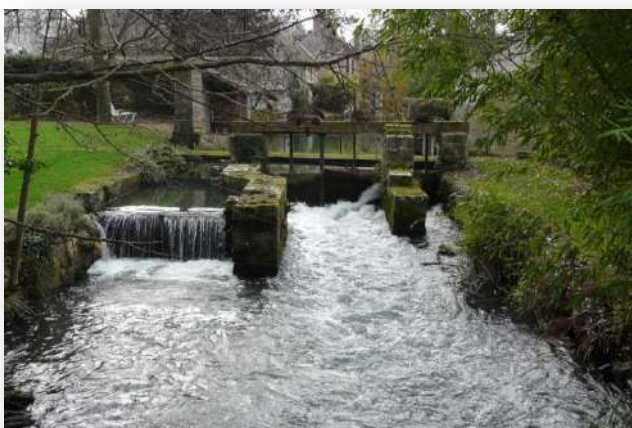
Photo 38: le moulin Faton dans Ferrières
